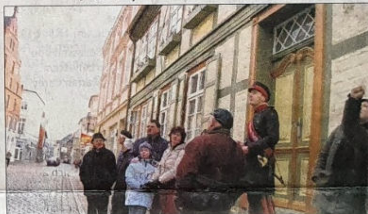
Das älteste Fachwerkhaus der Stadt wird begutachtet.
