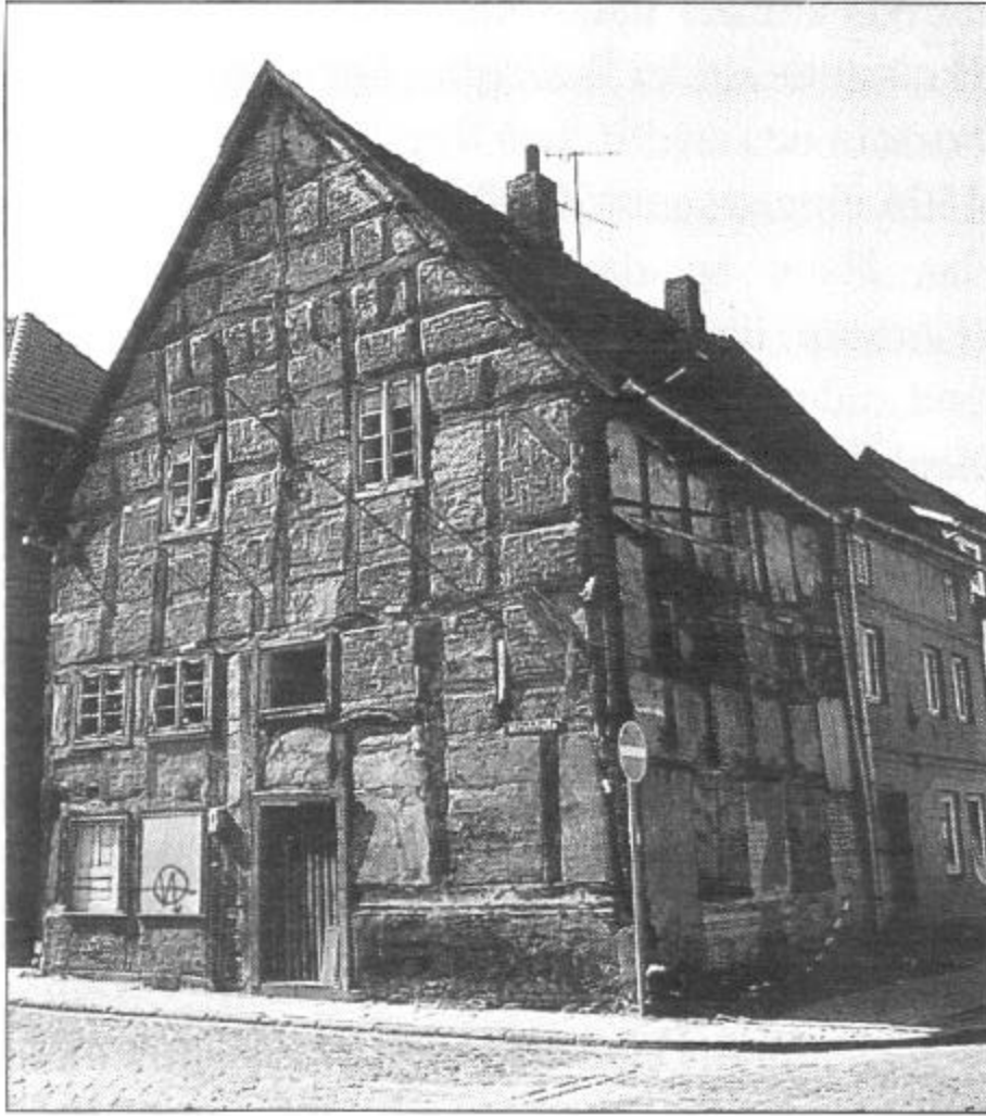
Fachwerkhaus in der Parchimer Mittelstraße 12. In der Längslinie schließt sich im Hintergrund das ursprünglich mit zum vorderen Haus gehörige Gebäude an
