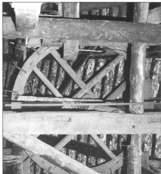
Aufzugsrad im Dachgeschoß des Hauses Lange Straße 24 Foto: Burghard Keuthe
